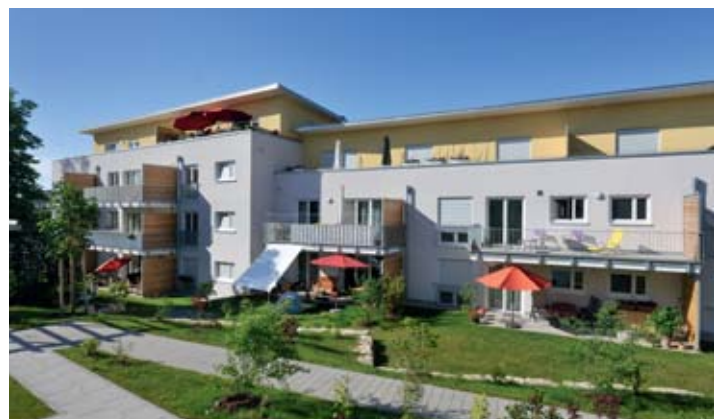
Neubau Matthäusstraße 2–6 nach KfW-Standard, Energieversorgung mit einer Luftwärmepumpe sowie solarthermische Unterstützung
