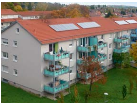
Umfangreiche Modernisierung: Dämmung, zentrale Heizungs- und Warmwasserversorgung, solarthermische Unterstützung, Balkonbauten
